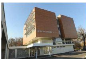
Hôtel de Guyenne avant travaux
